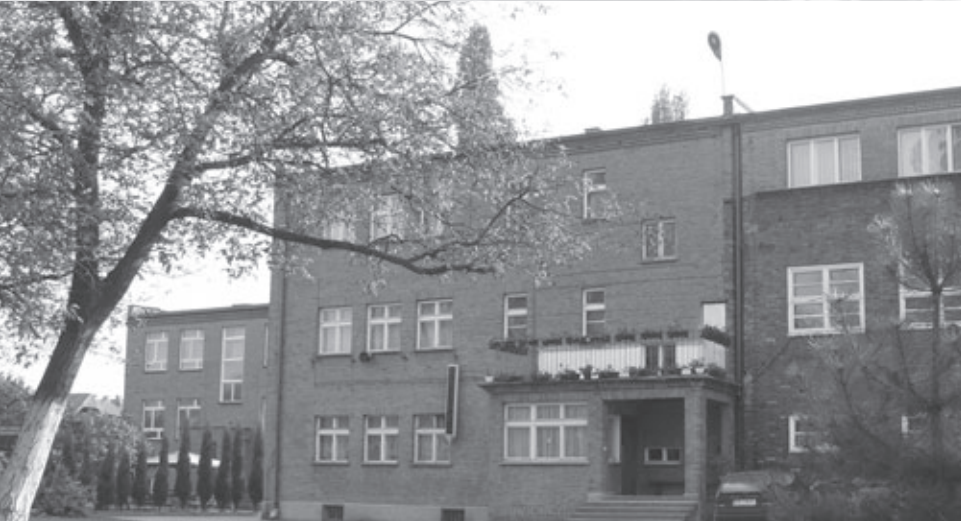
Budowle wzniesione za kadencji o. Wilczka.
